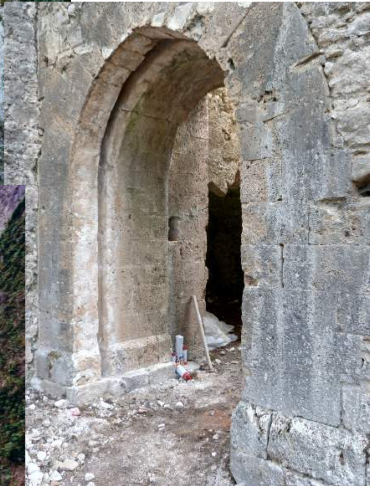
Fig. 15 Porta di ingresso alla struttura centrale del castello, con le evidenti scanalature per il passaggio di una saracinesca.
