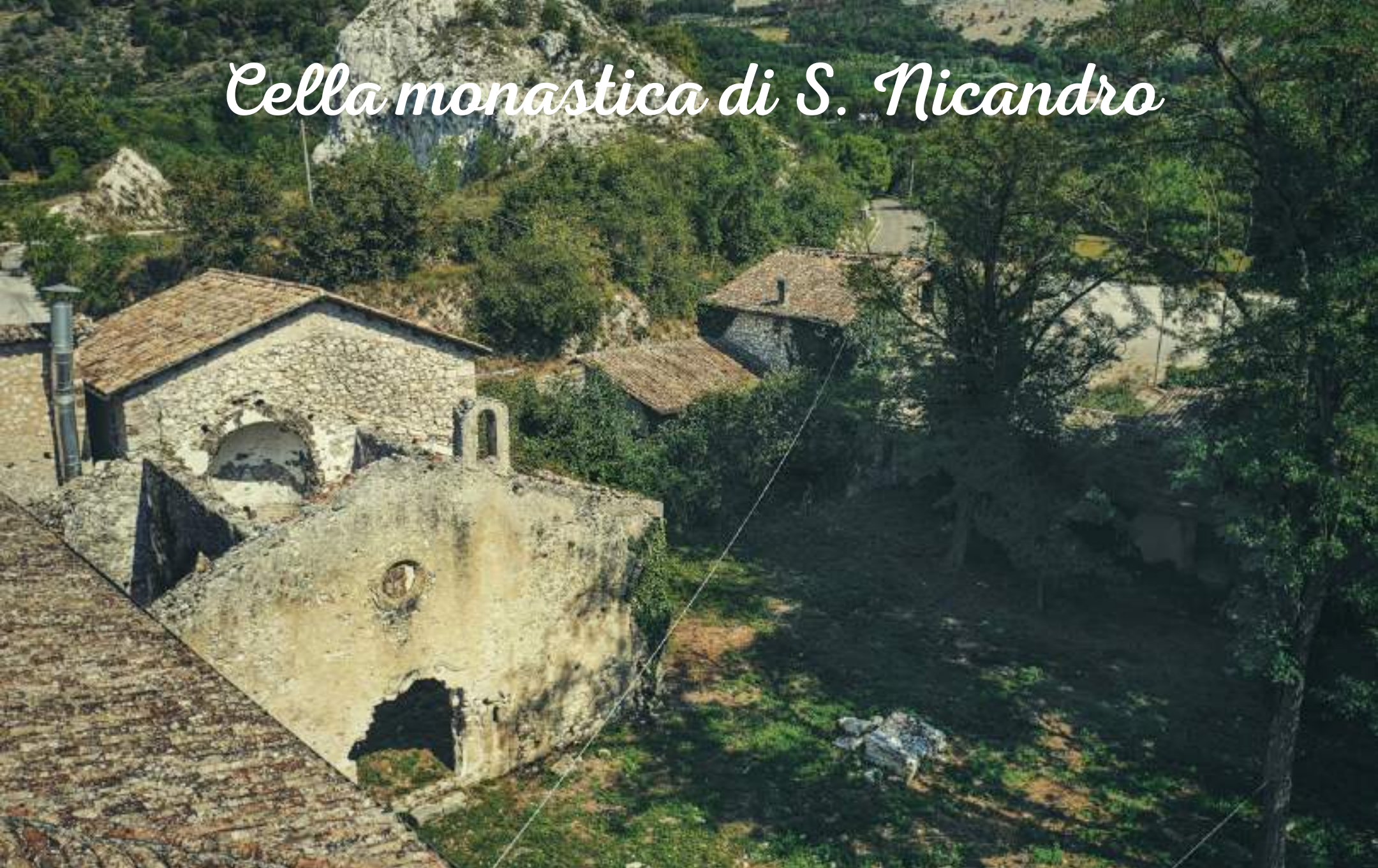
Fig. 41 Rudere della chiesa di S. Nicandro ed edifici del monastero. Ruins of St. Nicander church and building of the monastery.
