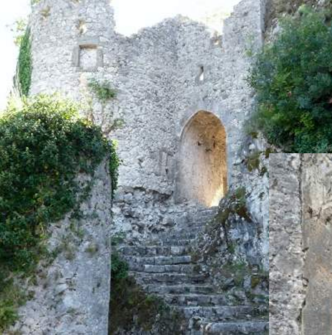
Fig. 13 Ingresso del castello di Vicalvi con porta e battiponte per il ponte levatoio; la scala che permette l'attuale ingresso è stata costruita successivamente alla dismissione del ponte levatoio.
