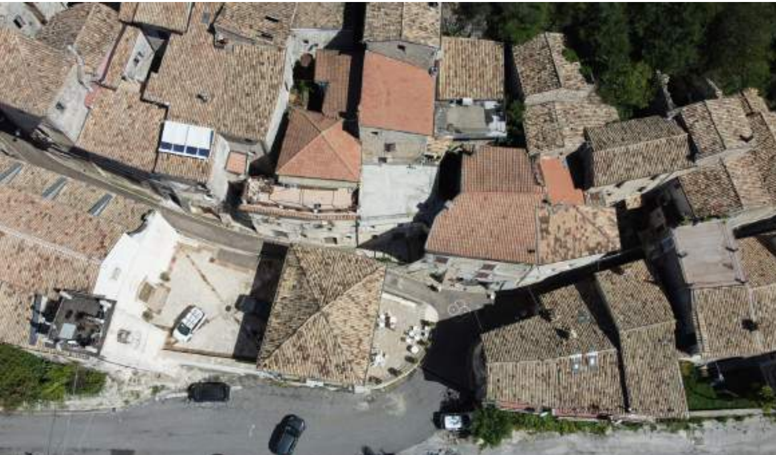
Fig. 20 Veduta delle case nei pressi dell'ingresso del paese, ex porta San Giovanni. View of the houses next to the entrance of the town, ex St. Jhon's door.
